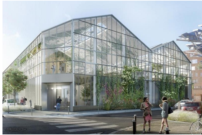
Food Hall - NANTES (44) - Construction et réhabilitation des anciennes halles Alstom
