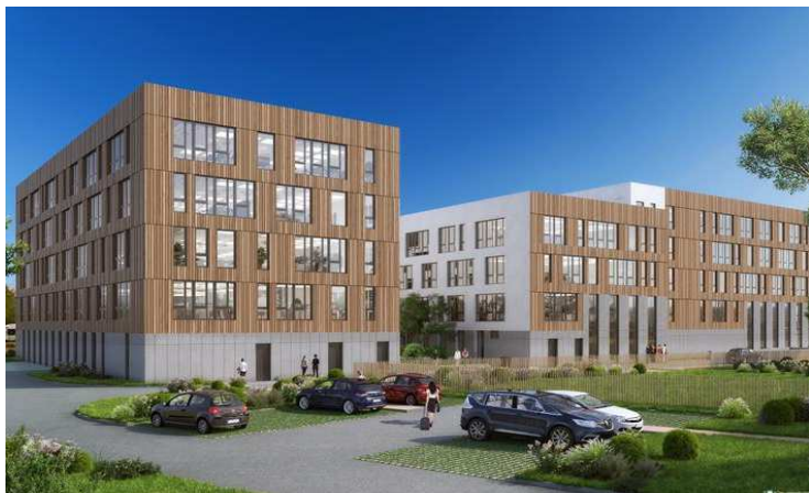
eKNOW - NANTES (44) - Construction d'un ensemble immobilier de bureaux et 248 places de stationnement
