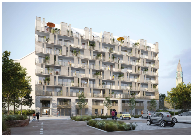
L'Atriole / Le Sand - GENTILLY (94) - Construction en cours de 24 logements collectifs, 24 logements sociaux et d'un ensemble immobilier de bureaux
