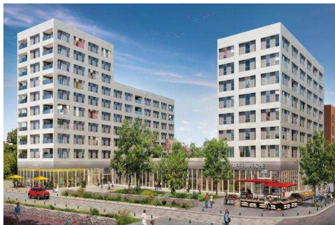
NEW CITY - RENNES (35) - Construction en cours de 127 logements & commerces
