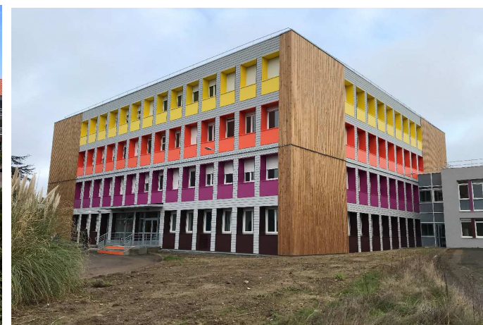
Collège Jacques Brel - Guérande (44) - Rénovation énergétique du collège
