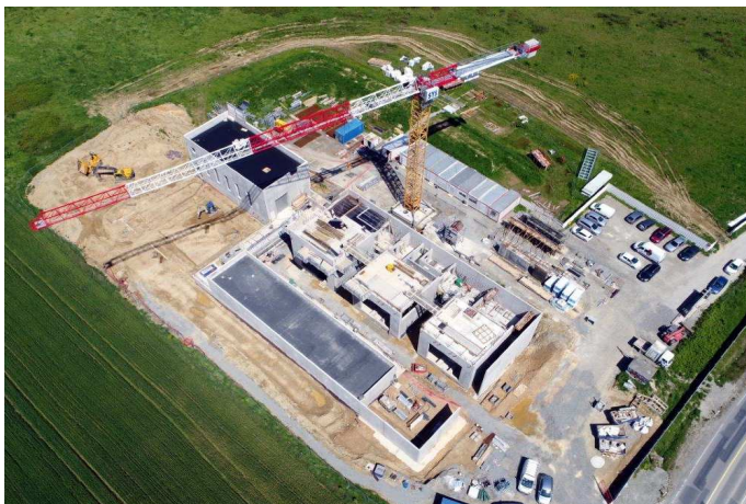
Poste Source ERDF - TIZE (35) - Construction d'un poste source 90/20KV
